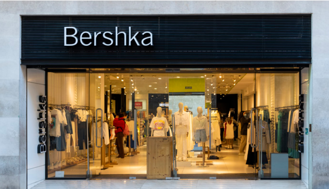
Es suggereix que les reixetes de les màquines de climatització formin un sol element amb el rètol identificador.
