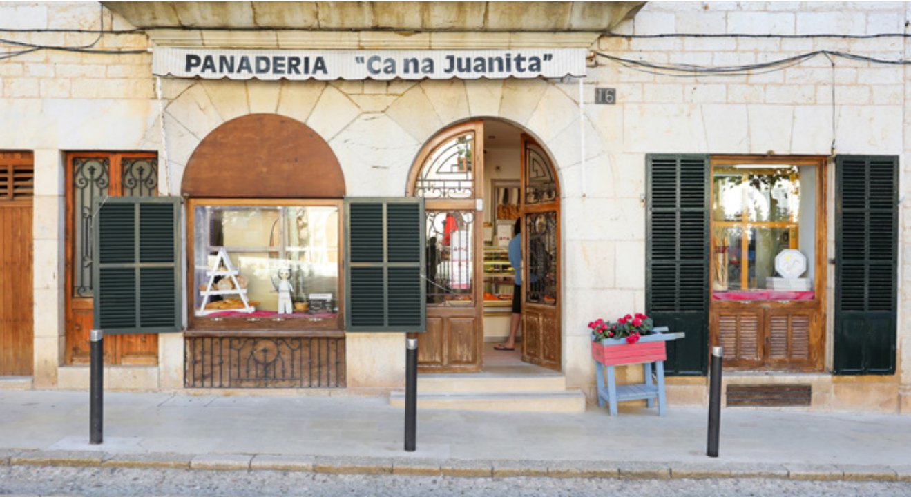
Per mantenir la identitat i la composició de l'edifici es recomana mantenir les fusteries i els tancaments que siguin originals.
