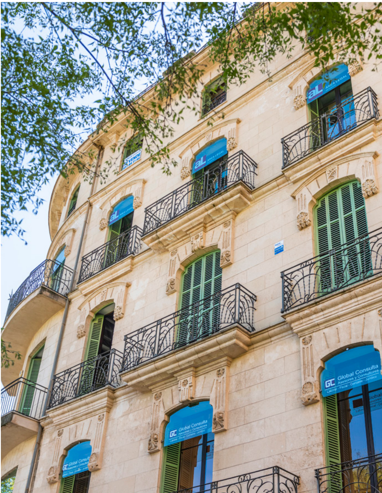
La instal·lació de rètols a les plantes pis no hauria d'amagar o desvirtuar els elements singulars de l'edifici, com ara balconades, baranes, galeries, motllures, emmarcaments, etc.
