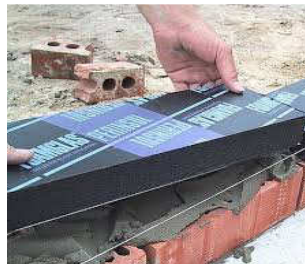
Aislamiento base muro Foamglas
