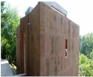
Sistema SATE corcho sin revestir a la intemperie
