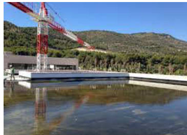
EPDM RESITRIX autoadhesivo. Prueba de estanqueidad
