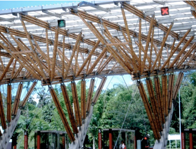
Estación de peaje en el eje cafetero, Pereira
