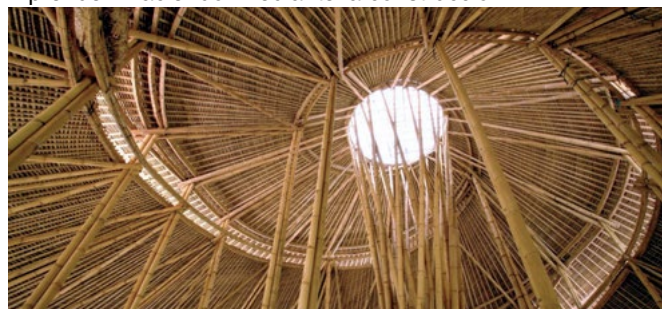
Posibilidades del diseño y construcción en bambú
