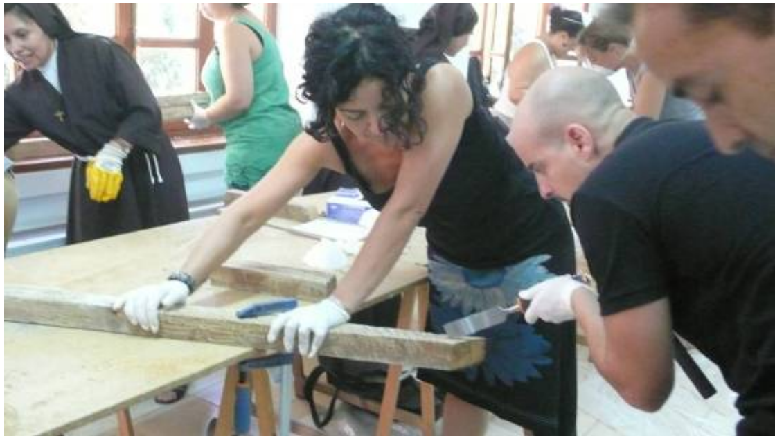
ALUMNOS TRABAJANDO EN EL TALLER DE PRACTICAS DE RESTAURACION
