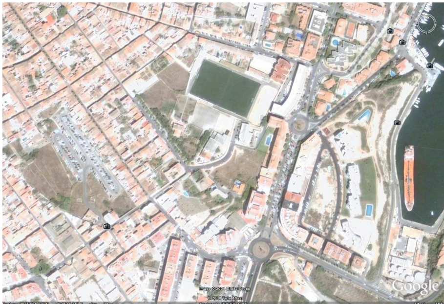
Estat actual de la Sínia Bep Frare.
